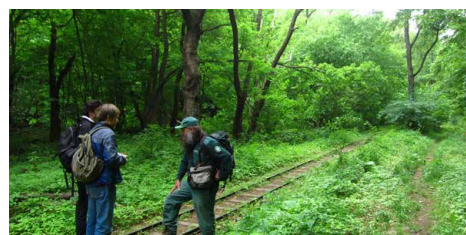
A fakitermelést szolgáló régi kisvasút pályájának maradványai a patak völgyében. A Csarna-völgyig tartó szakasz ugyanakkor ma is működik, Kemencei Erdei Múzeumvasút néven.
