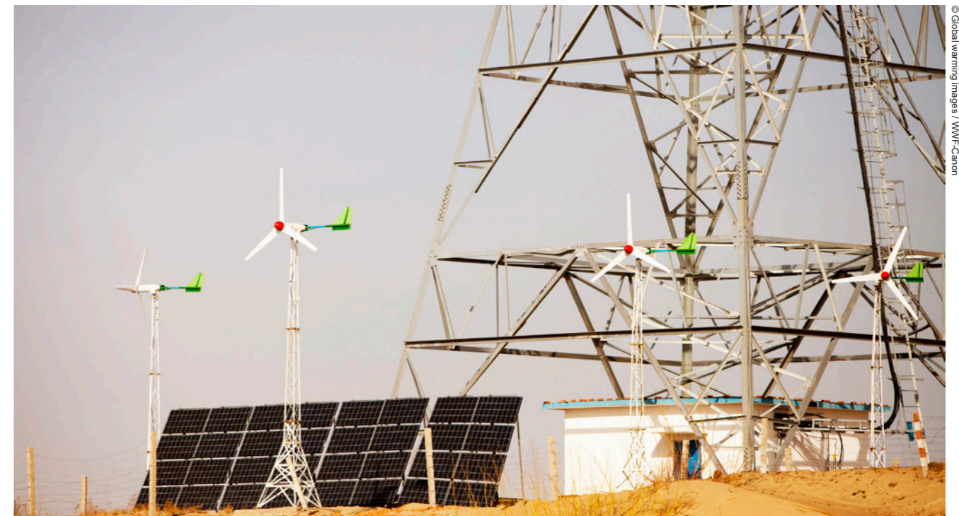
Szél-, és naperőművek által ellátott mobil adótorony Kínában
